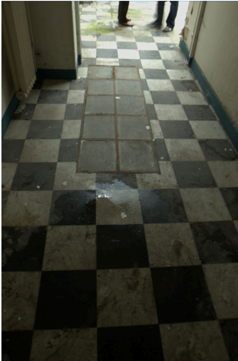
Plaques de verre permettant l'éclairage du sous-sol
