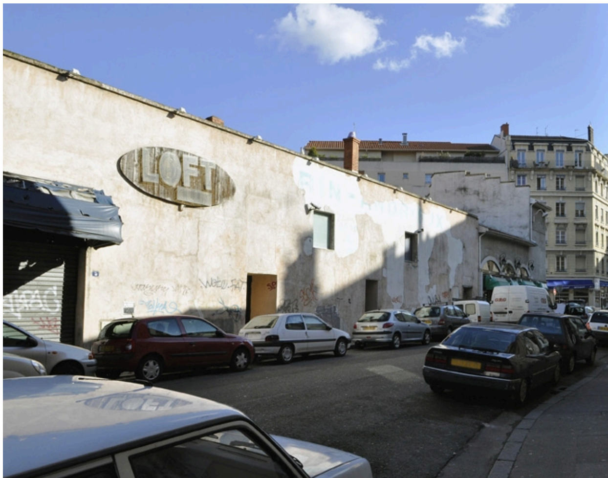
Vue générale ouest
