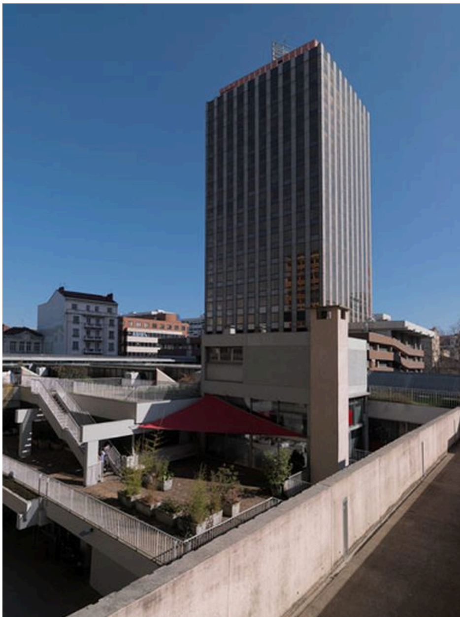
Vue depuis le sud-ouest.
