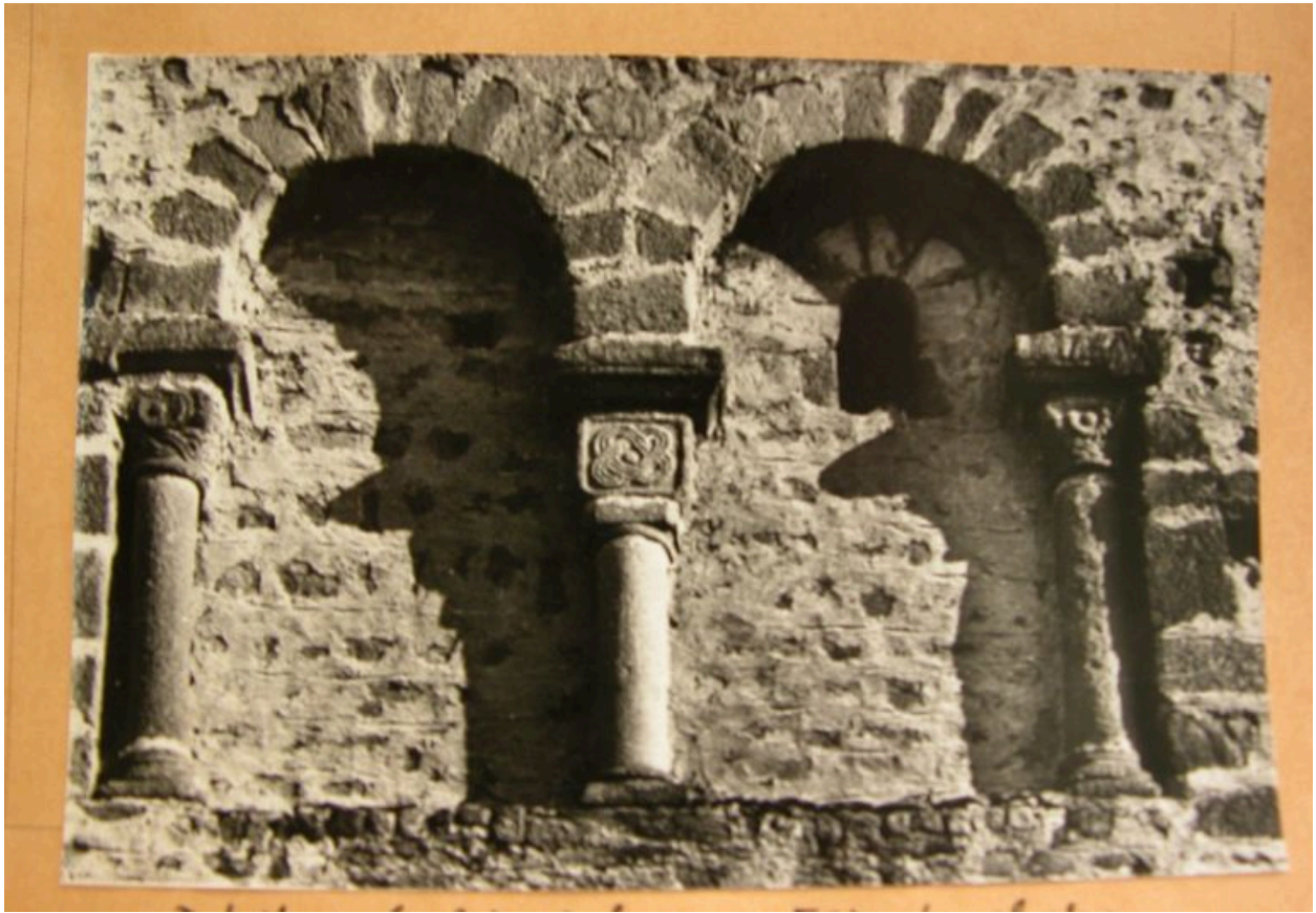
Détail baies aveugles de la façade est du clocher. Photo ancienne de 1973. photographie, 1973 AD Loire. 1111 VT 126
