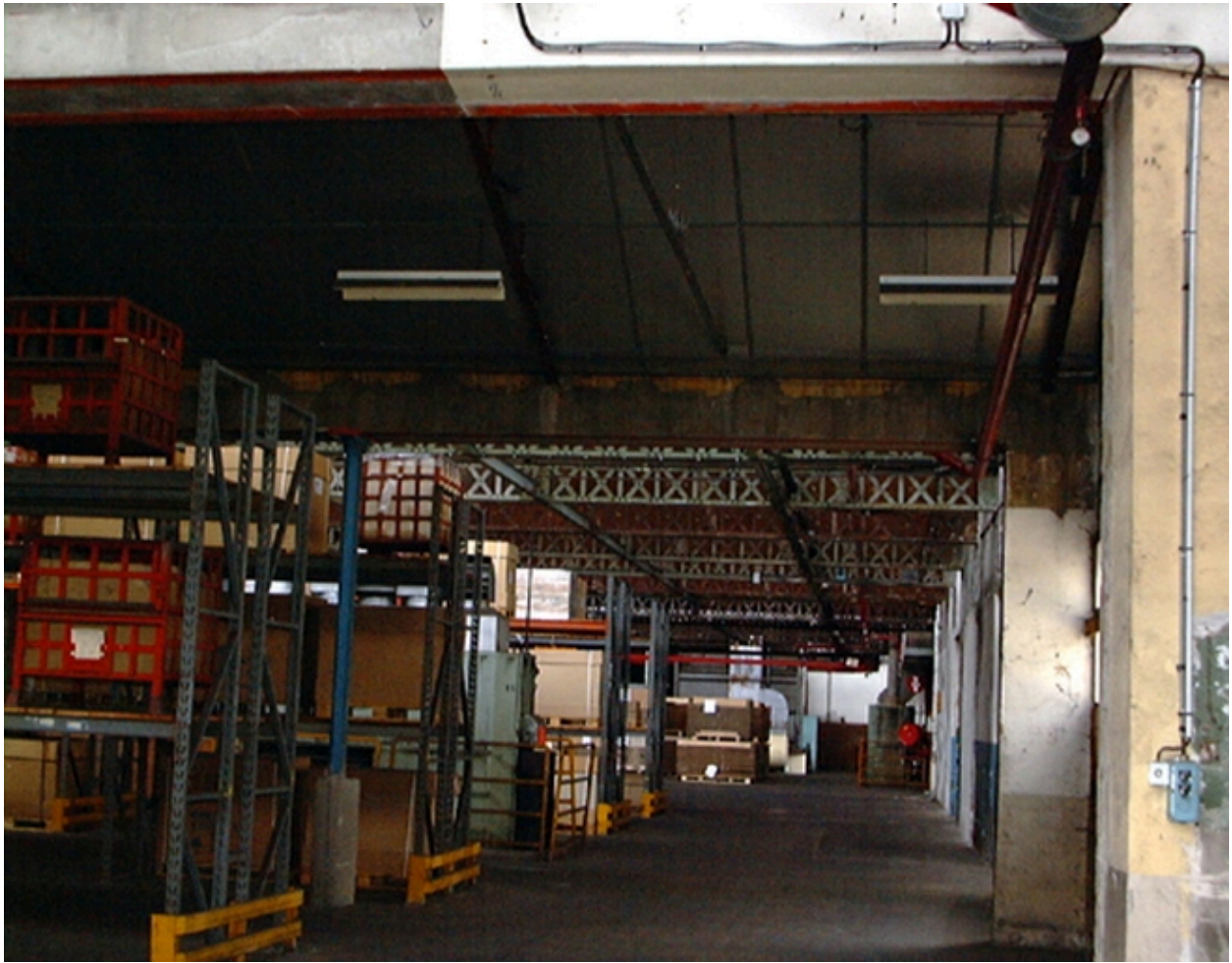
Vue nord magasin de stockage
