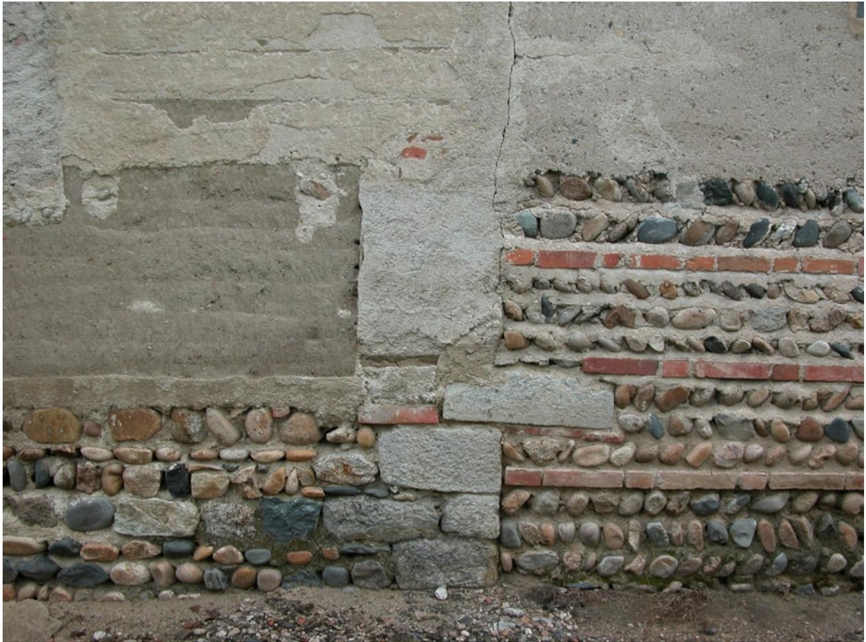
Détail de maçonnerie (entre l'étable et l'écurie, mur ouest) : soubassement en maçonnerie de galets et briques.
