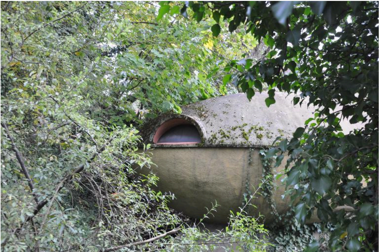
Vue sur la "chambre-noisette" nord greffée sur la tour d'escalier
