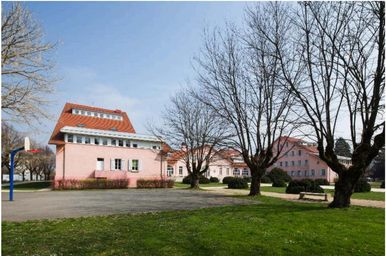
Bât. A : aile ouest et terrain de basket
