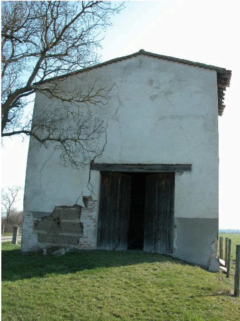
Vue d'ensemble de la face avant sur le mur pignon.
