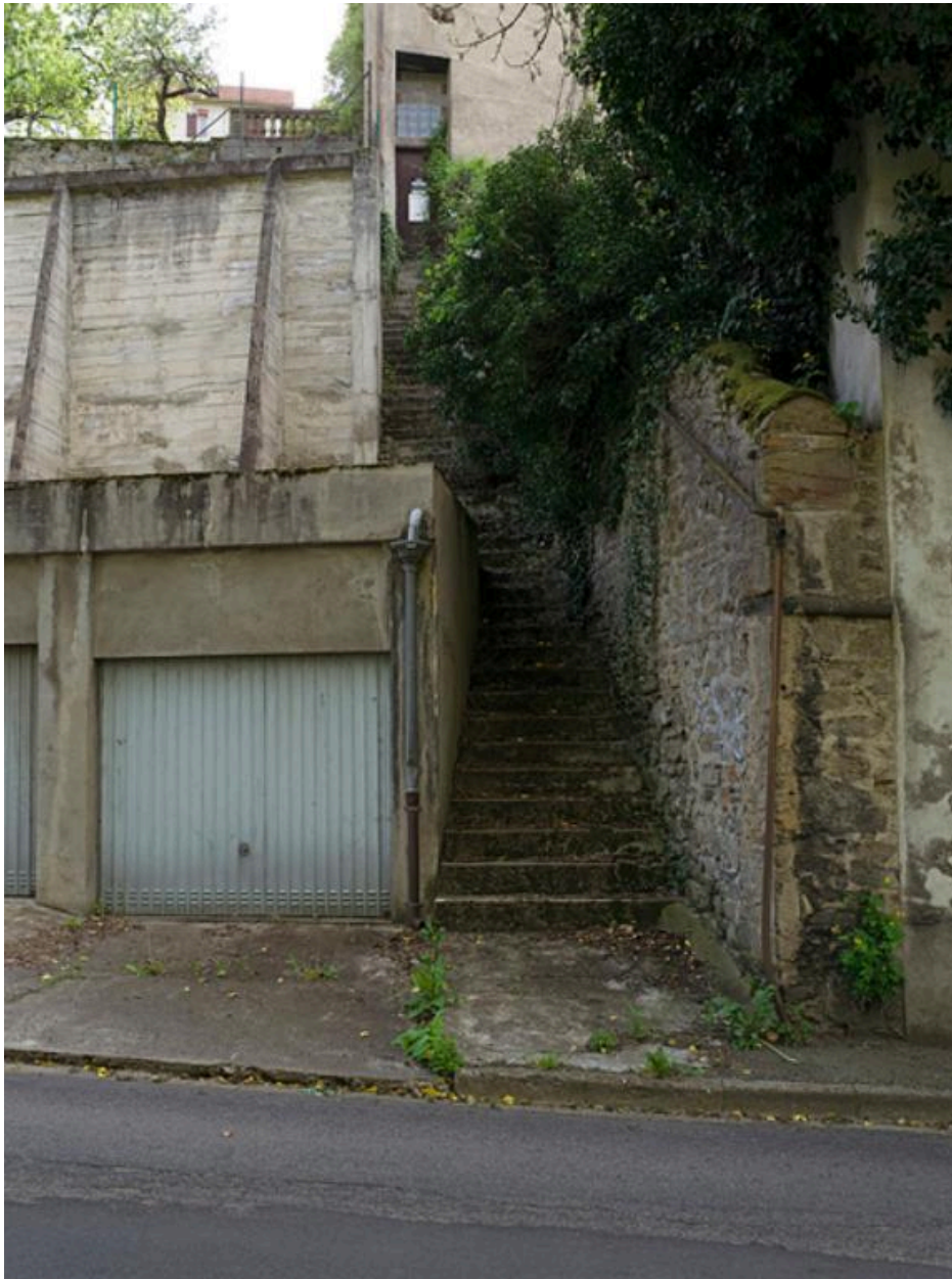
Escalier d'accès à une maison en contre-haut de l'avenue Pierre-Guérin, depuis la rue.
