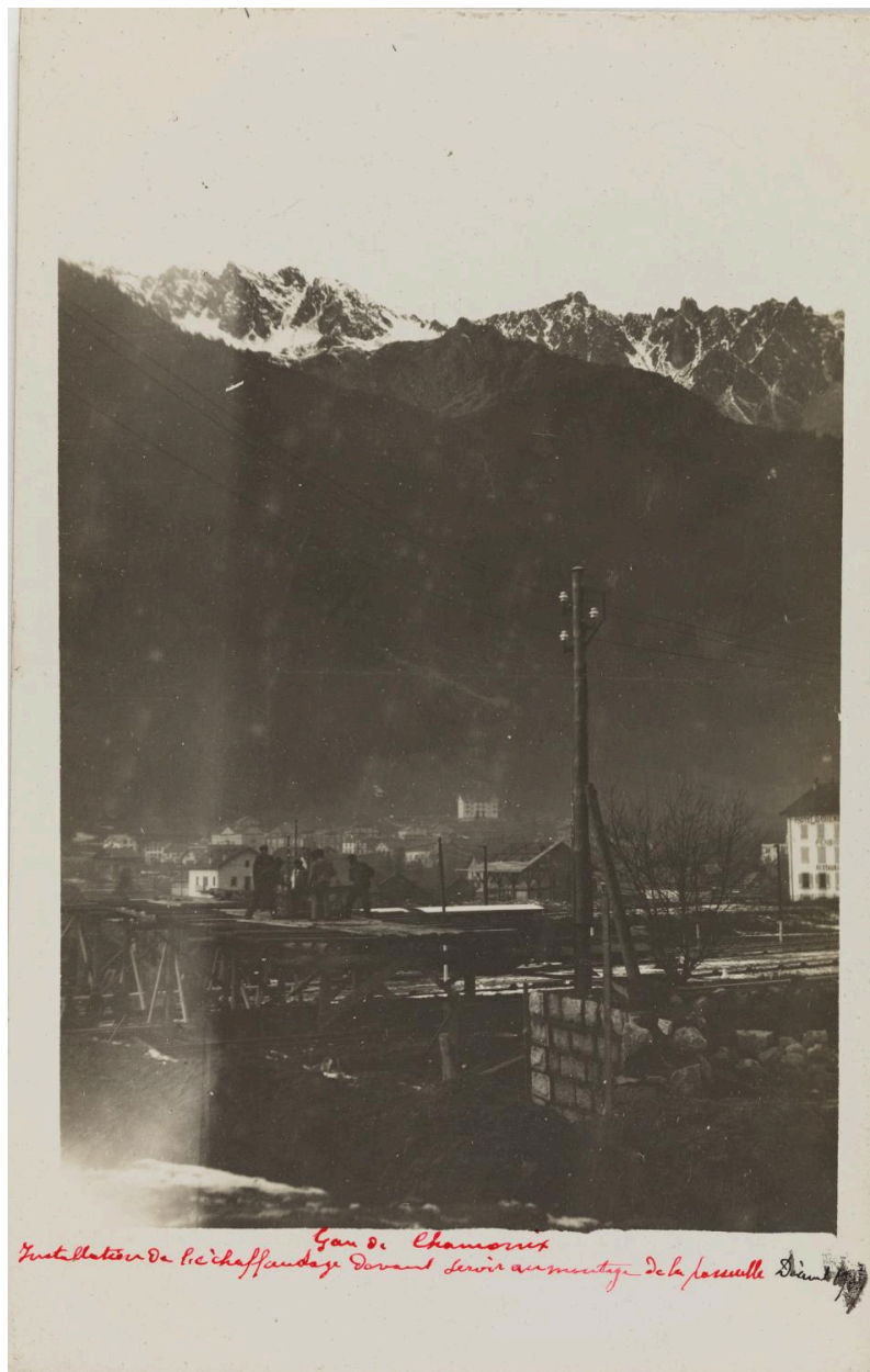
Gare de Chamonix, Installation de l'échafaudage. 1907 (AD Haute-Savoie : 36 Fi 535)
