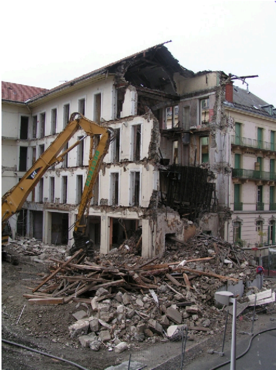
Démolition de l'hôtel en 2005
