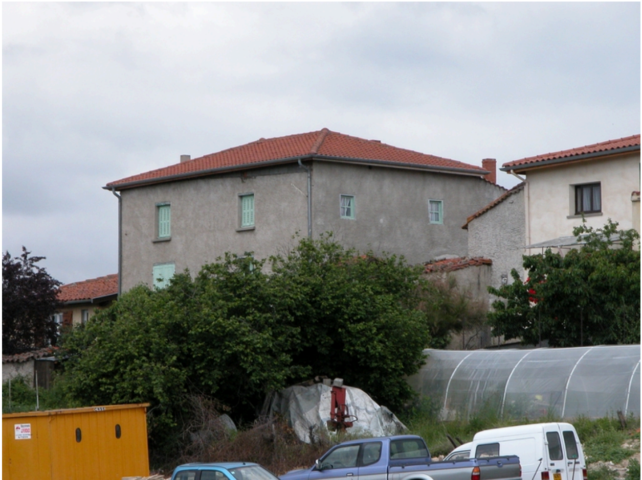
Vue générale depuis l'est.
