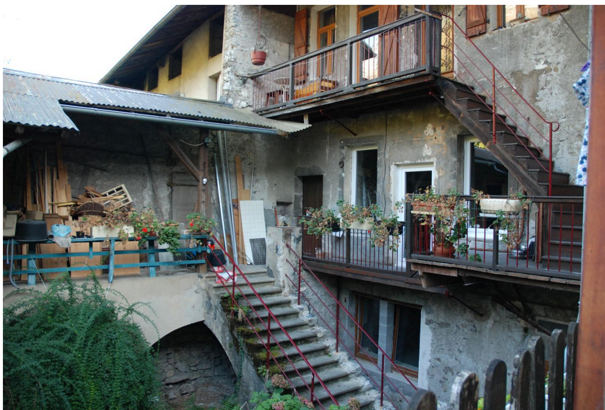
Maison, immeuble, 100 rue Louis Blanc-Pinget (2018 E1 1797). Elévation sur cour.
