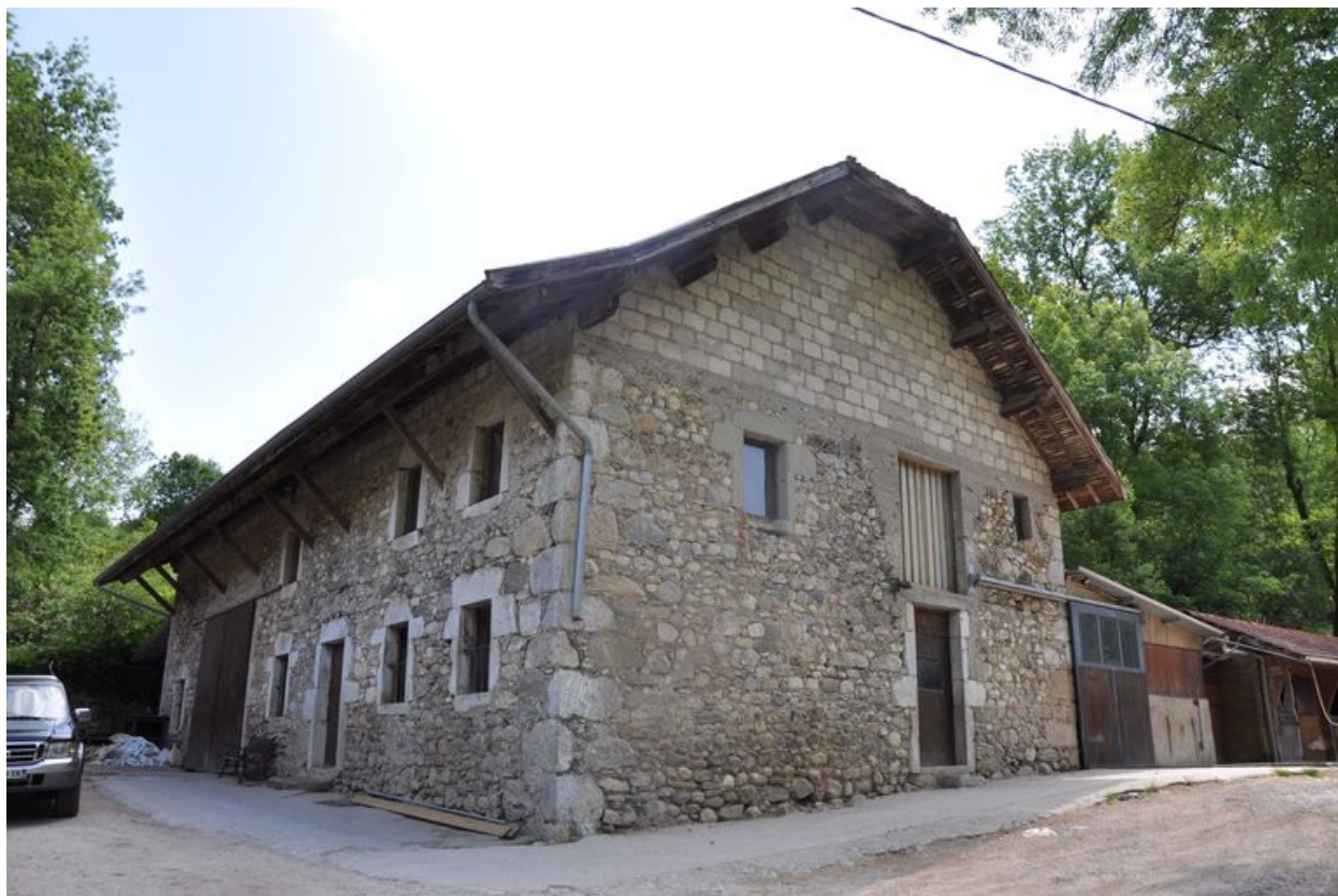
Elévation nord-est du bâtiment secondaire
