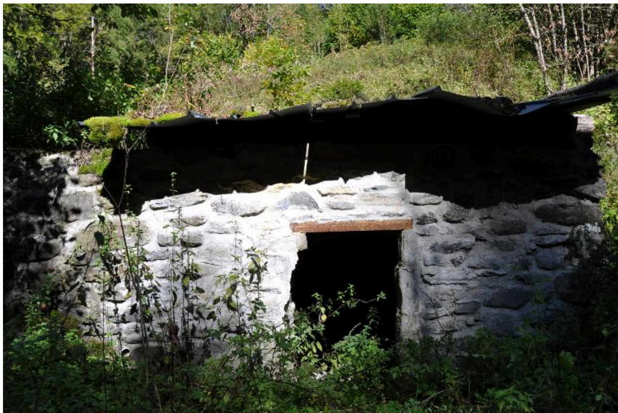
Rez-de-chaussée du bâtiment de la scierie transformée en remise
