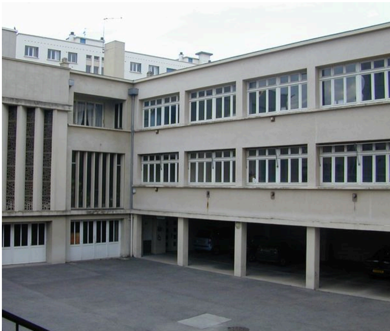
Vue de l'angle sud-ouest de la cour nord. Façade nord de l'église ; à l'angle sacristie et logement du gardien
