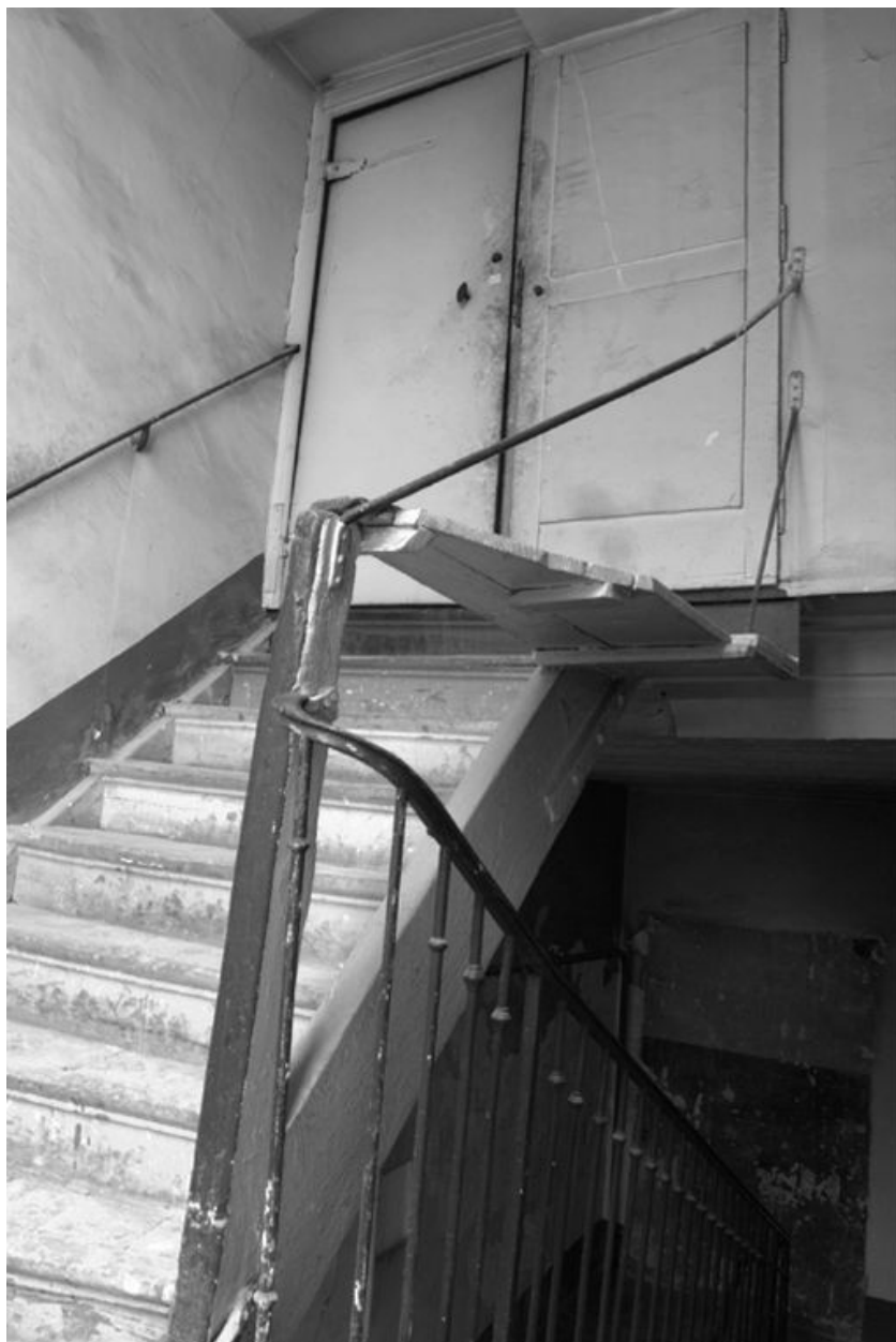
Vue de la dernière volée de l'escalier
