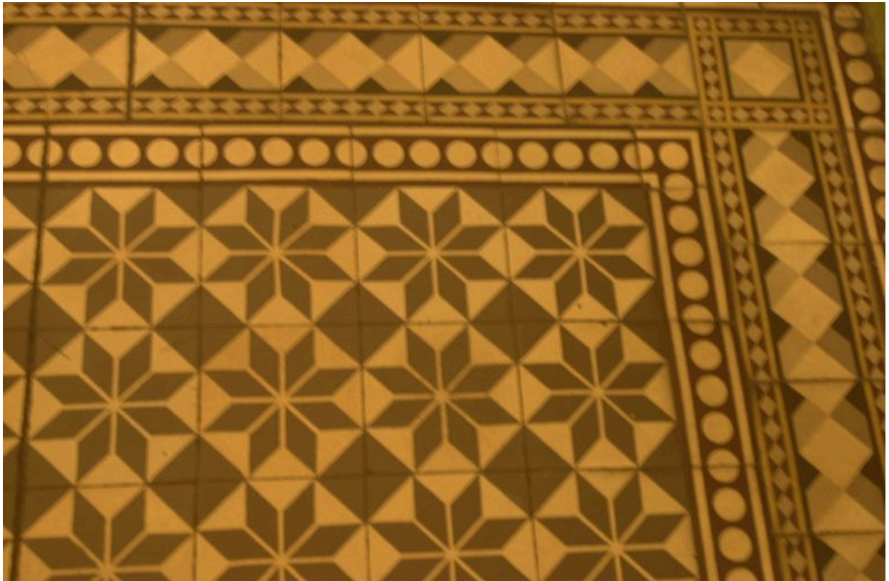
Carrelage du vestibule, détail
