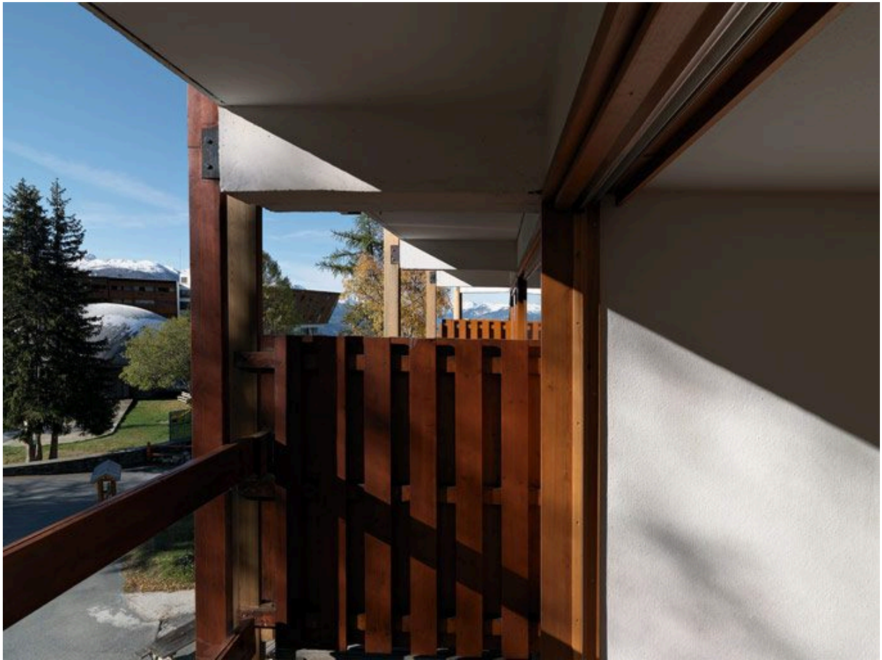
Façade sud. Séparation entre les terrasses
