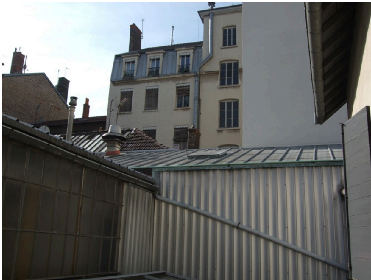
Vue des toiture
