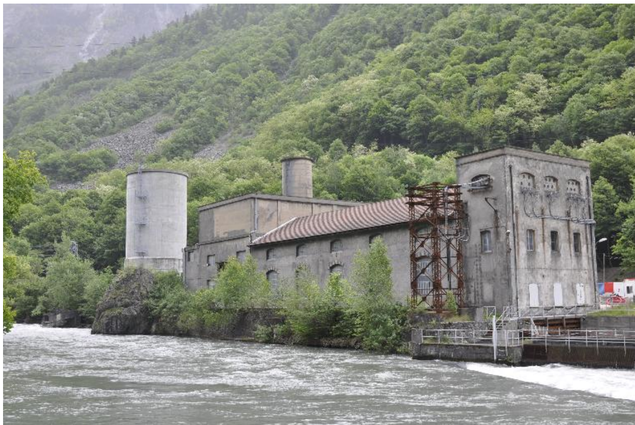
Vue de l'ensemble des bâtiments de la centrale et de la cheminée à équilibre
