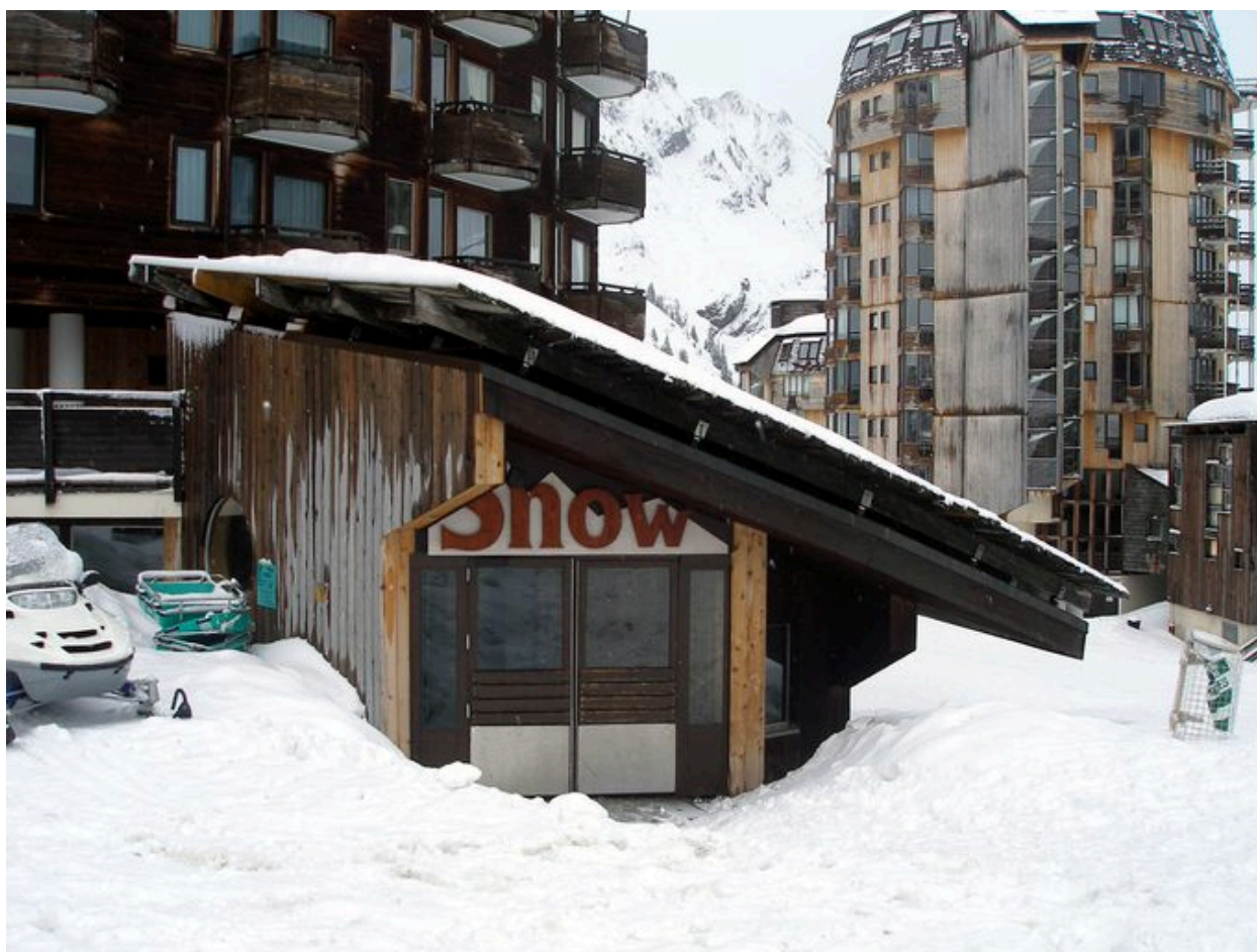
Détail de l'entrée aval
