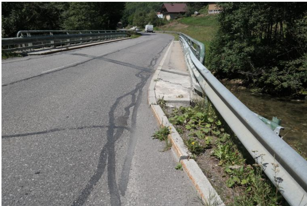
Pont des Portes, vue de la chaussée et des gardes-corps
