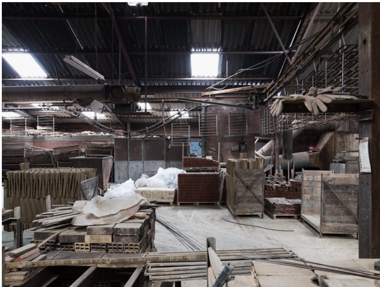
Vue d'ensemble intérieur de la tuilerie
