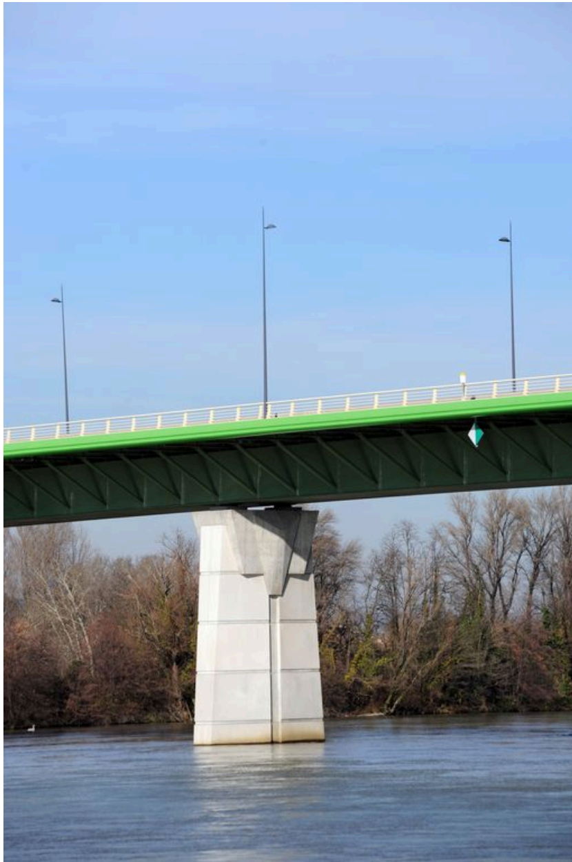
Pile, face aval, vue générale (depuis la rive gauche)
