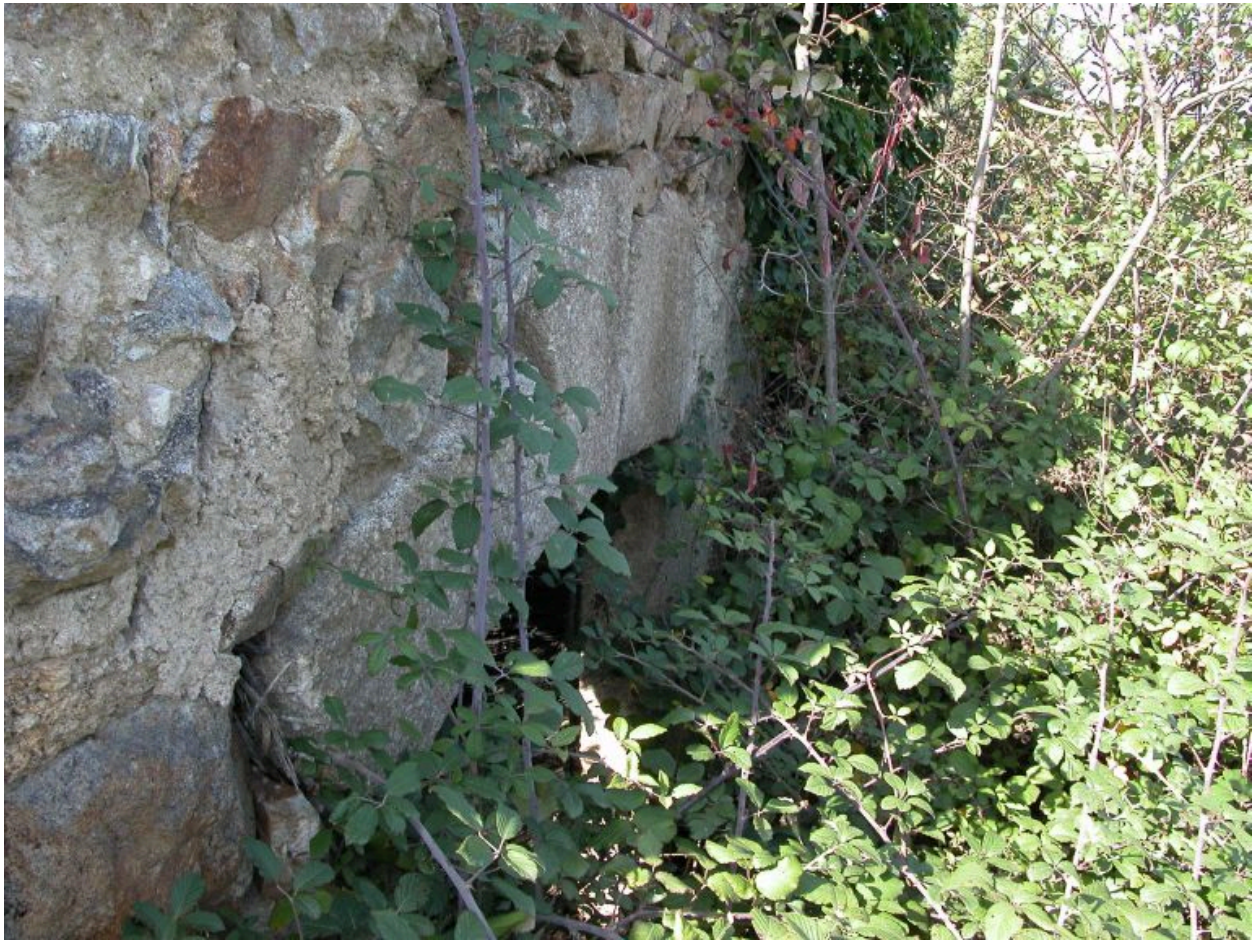
Détail de la baie au linteau en arc et à claveaux.
