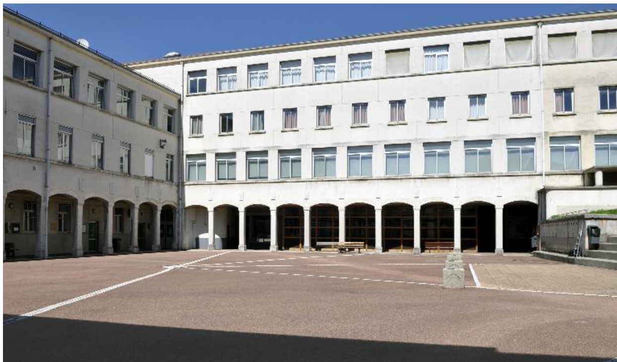
Grande cour, élévation du bâtiment B, depuis le sud-est
