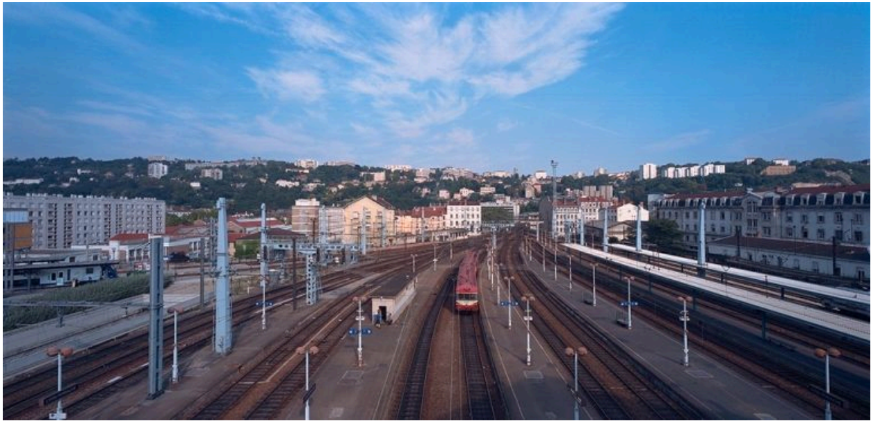
Vue d'ensemble du réseau ferré vers l'ouest depuis le toit de la grande halle
