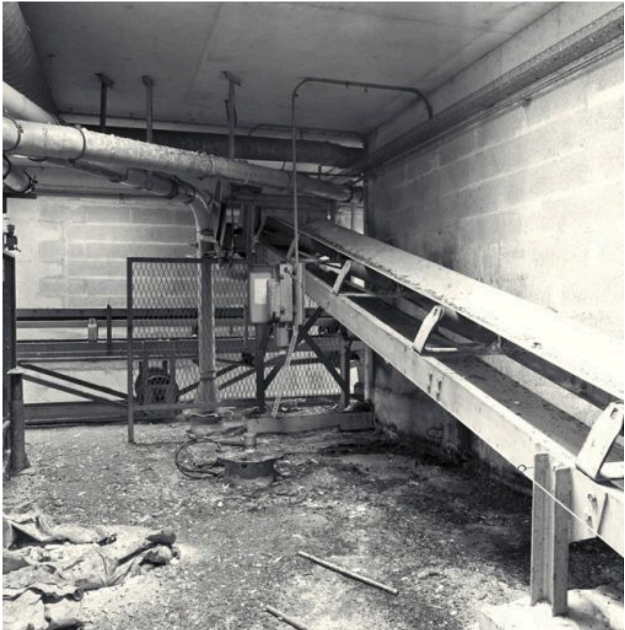
La galerie centrale entre les silos et la cage des élévateurs : vue du transporteur à bandes depuis la cage des élévateurs
