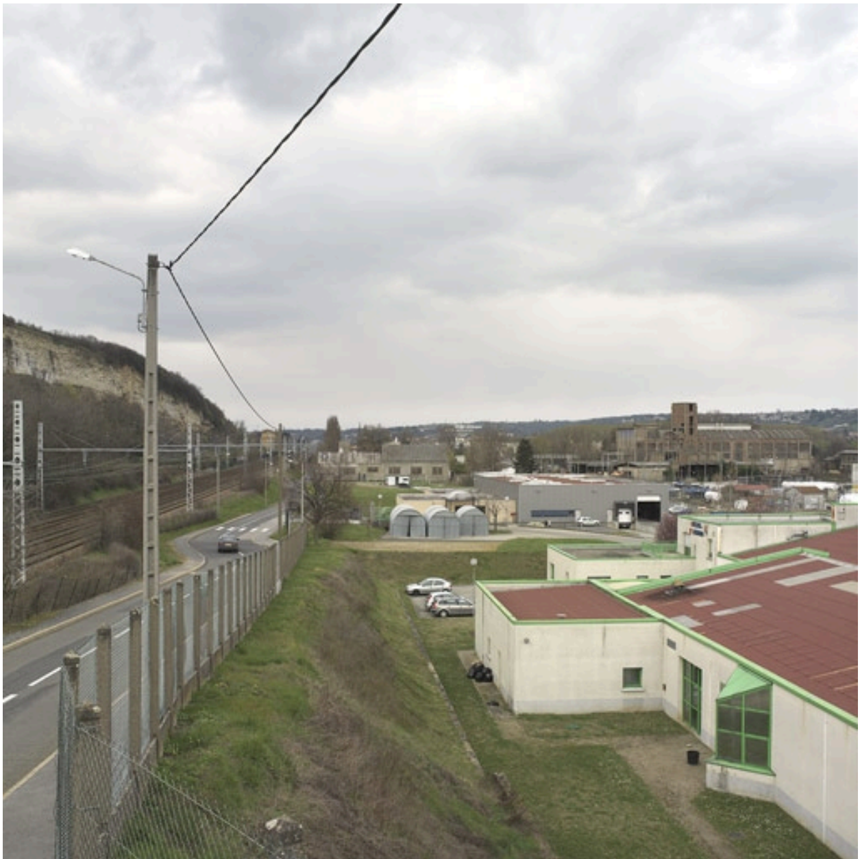
Vue d'ensemble sud
