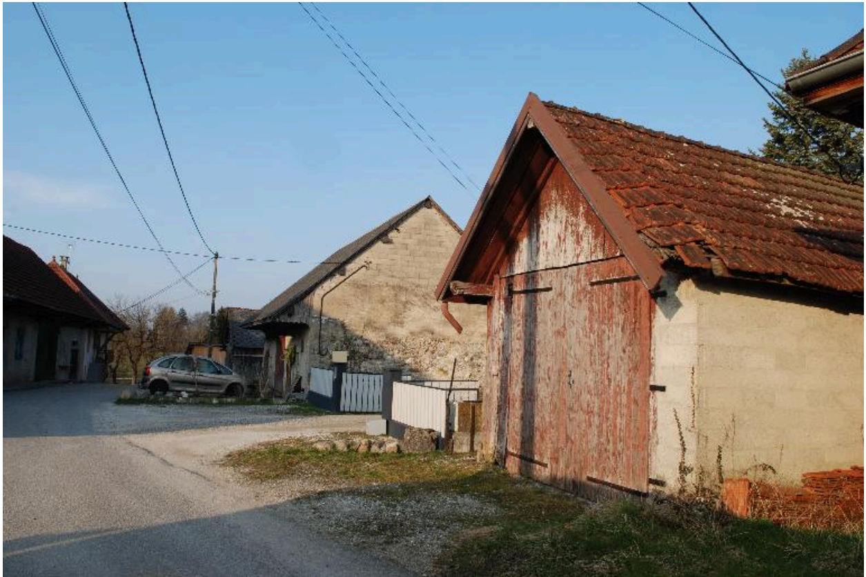
Vue d'ensemble de la remise.
