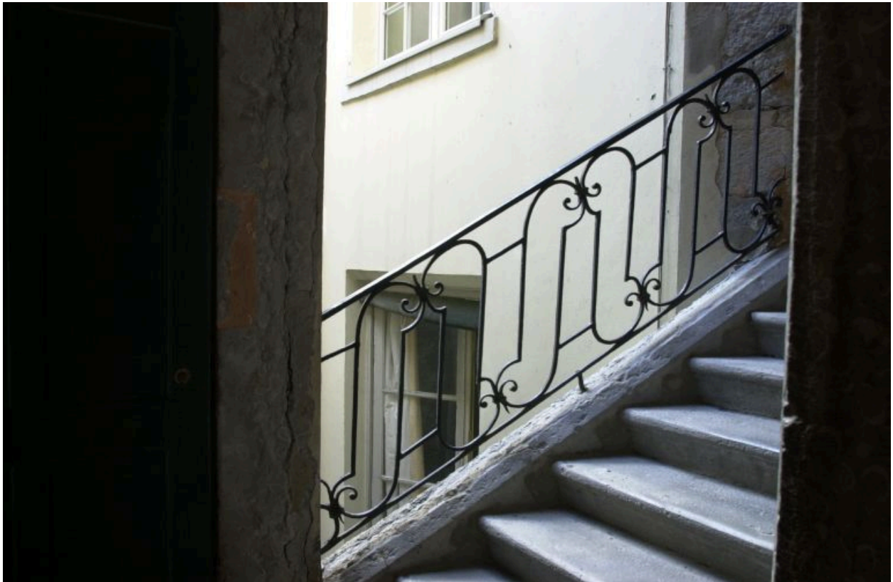
3e étage d'escalier, détail de la rampe
