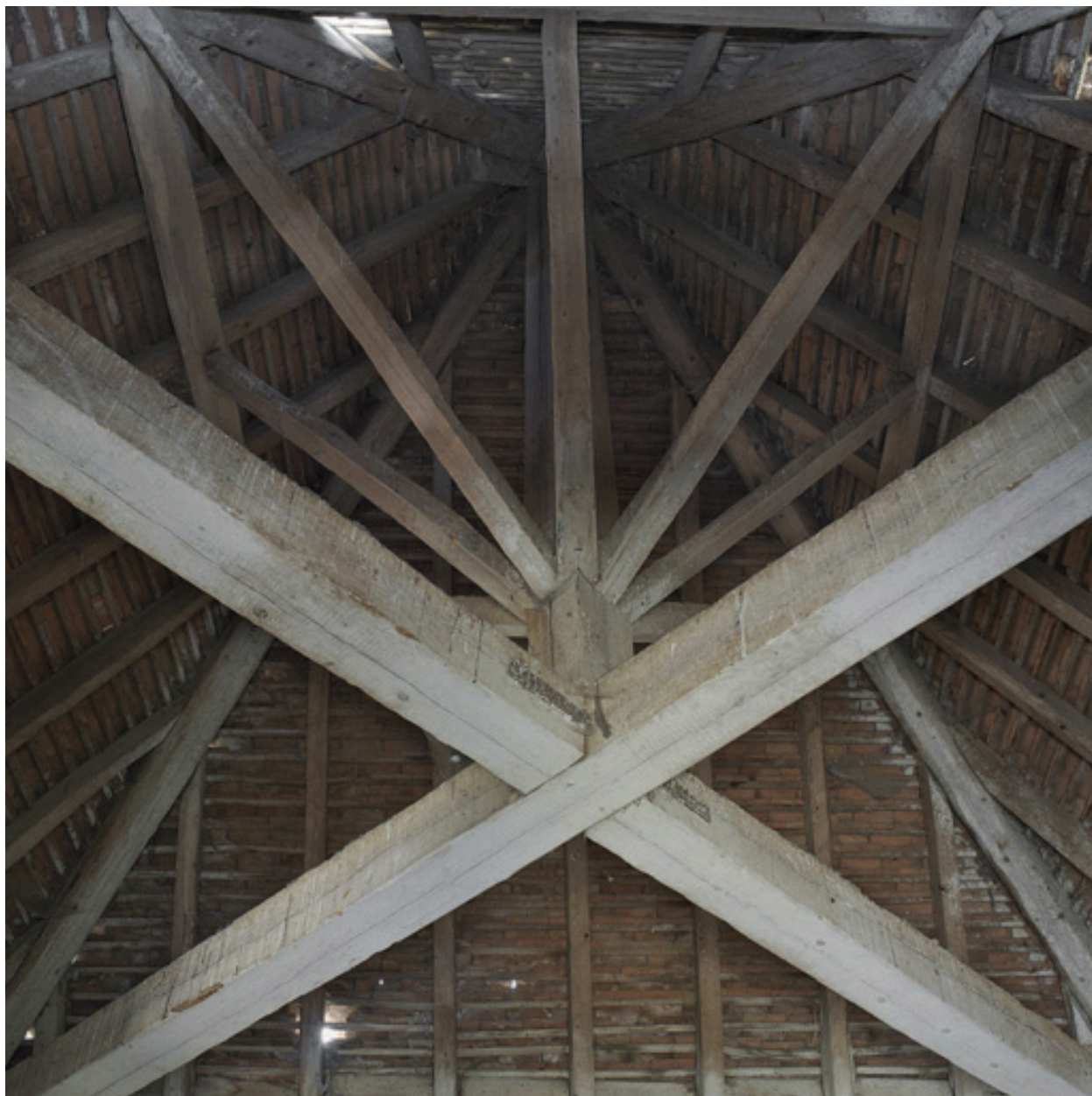
Vue intérieure de la charpente.
