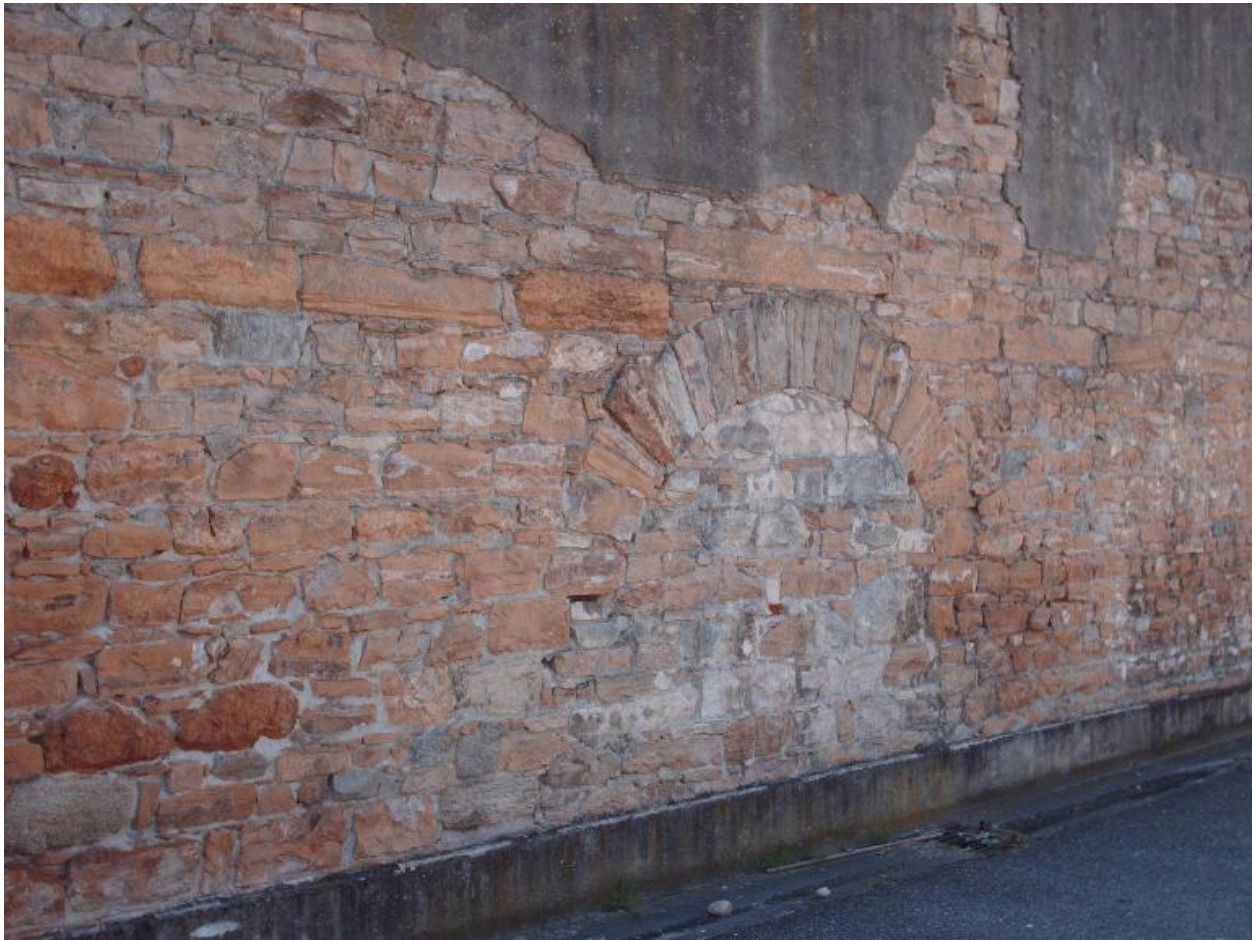
Etat en 2010 : mur d'enceinte avec arcade bouchée
