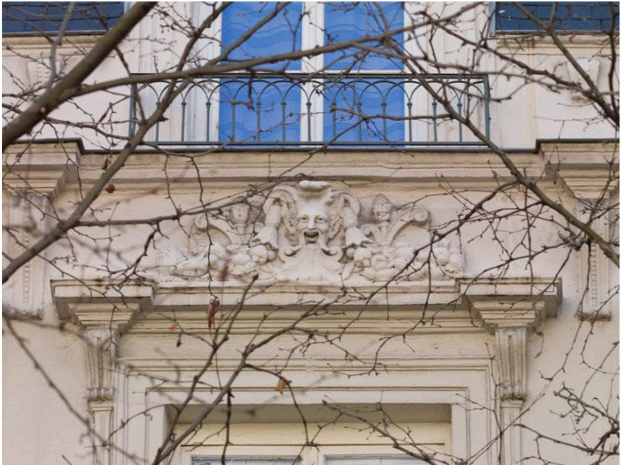
Détail d'un linteau de fenêtre en remploi au 2e étage, partie droite
