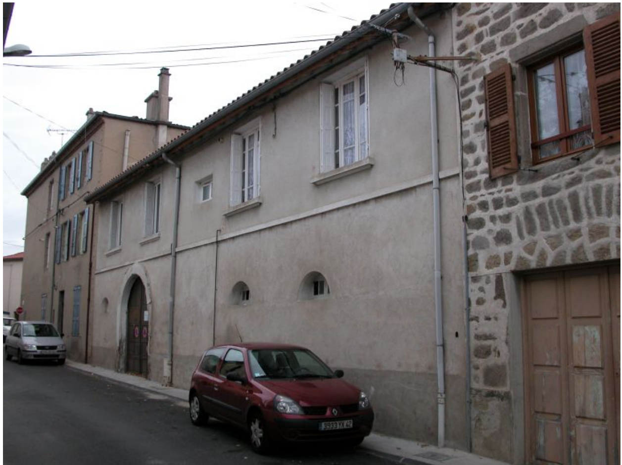
1986 AE 347. 24 rue de Saint-Anthème. Maison avec communs, vue d'ensemble des communs, cuvage, sur rue des Carrières.
