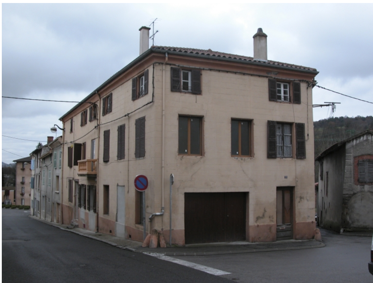
Îlot 16. Saint-Vincent (place) 12. Vue générale des façades sur la place.
