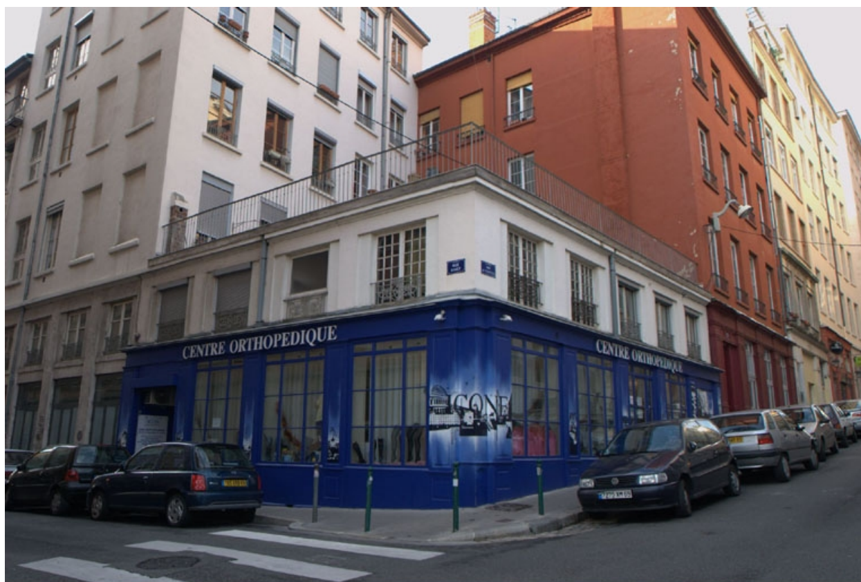
Vue générale sud-est
