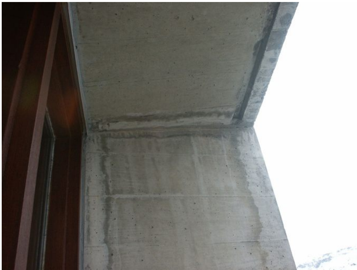
Détail d'un encadrement de fenêtre
