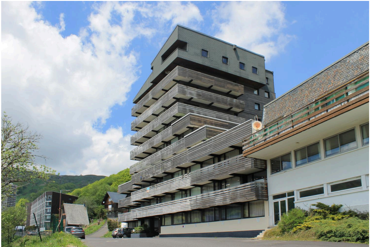
La résidence Les Gentianes vue du sud-est, 3 rue Marcel-Gauthier (architectes Faye et Tournaire).
