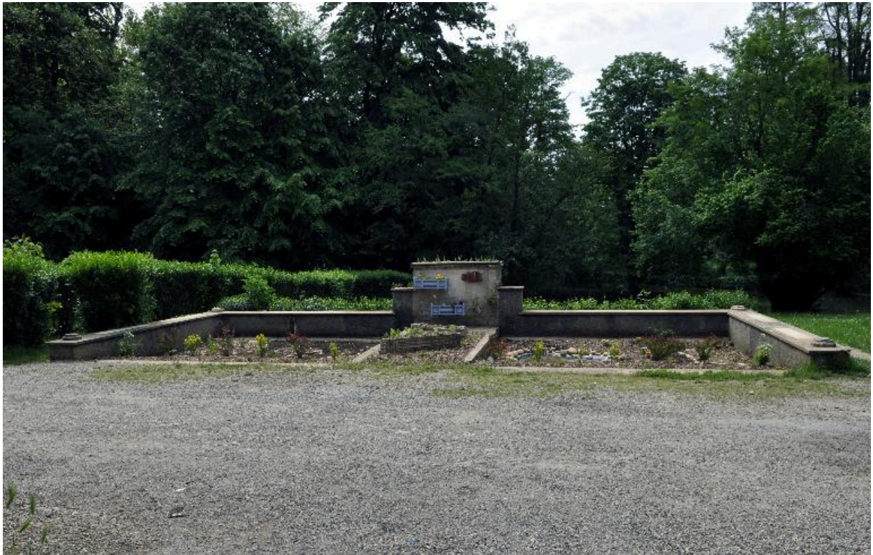
Bassin (actuellement parterre)
