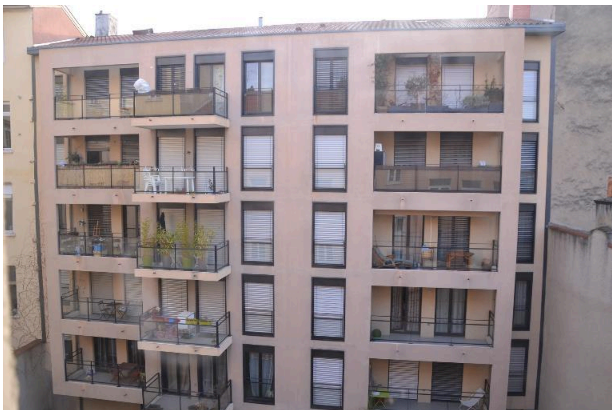
Vue d'ensemble façade ouest
