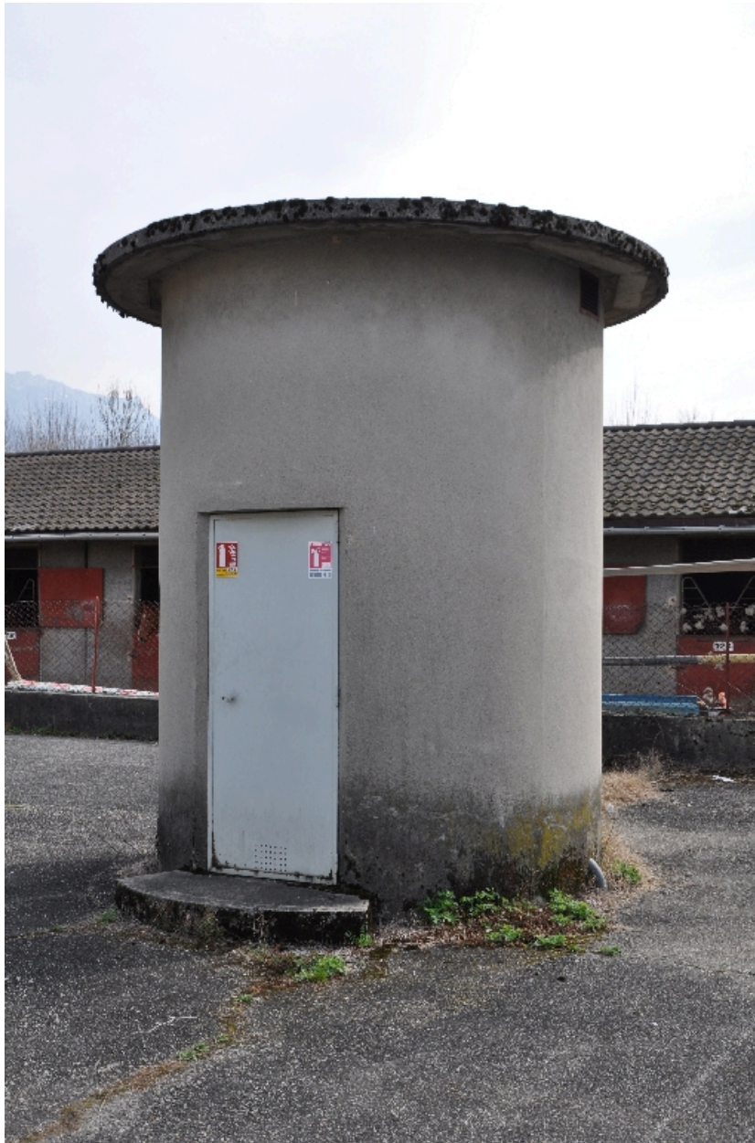
Puits dans la cour arrière
