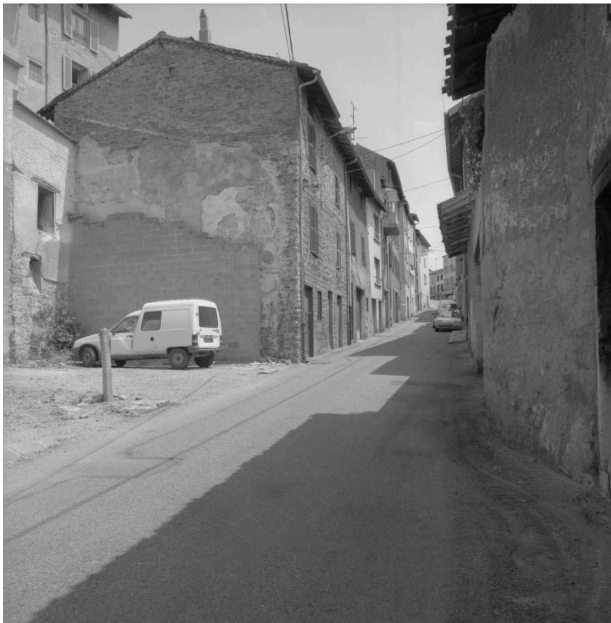
Vue de la maison située au 21 rue Philippe Raymond, offrant un mur pignon en pisé surélevé en moellons enduits, de l'ouest.
