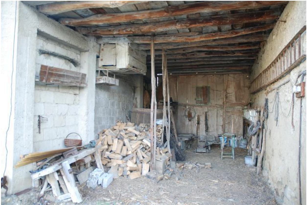
Vue intérieure de la remise.
