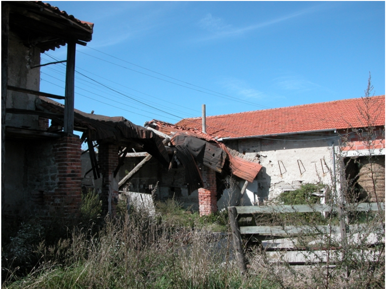
Vue de la grange-étable nord, partie ouest.
