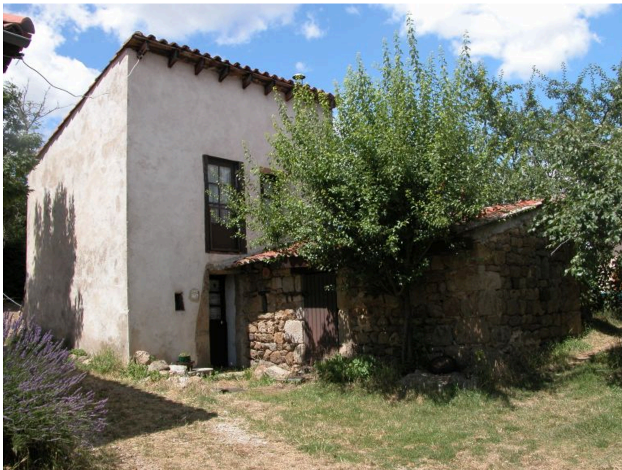
Quérézieux (1986 AM 62). Edifice agricole, vue d'ensemble.
