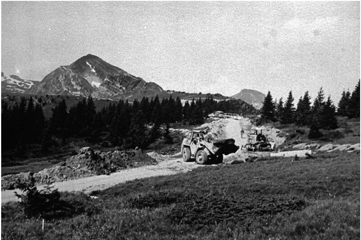
Chantier de la route depuis les chalets d'alpage vers le col d'Avoriaz, 1958-1961
