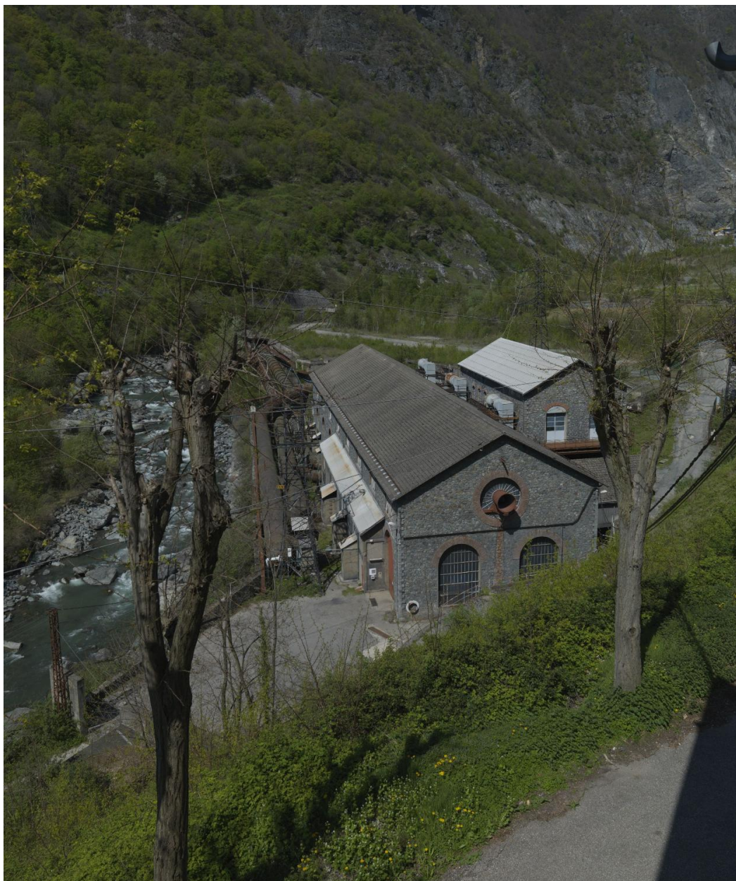
Vue de la centrale de Rioupéroux
